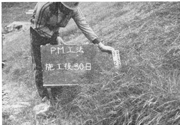
写真-1 PM工法実施後30日
